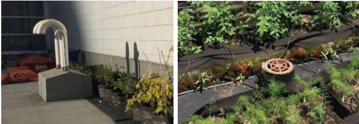
Figure 7. Exemple d'édicules sur le toit.
