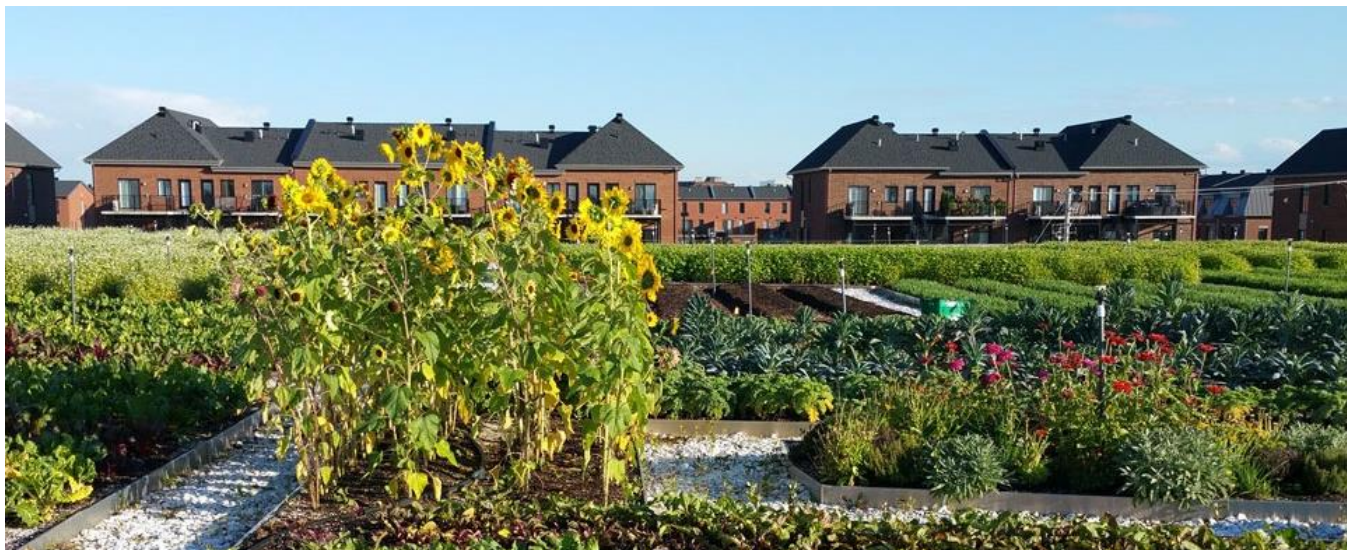
Vue du toit du IGA
